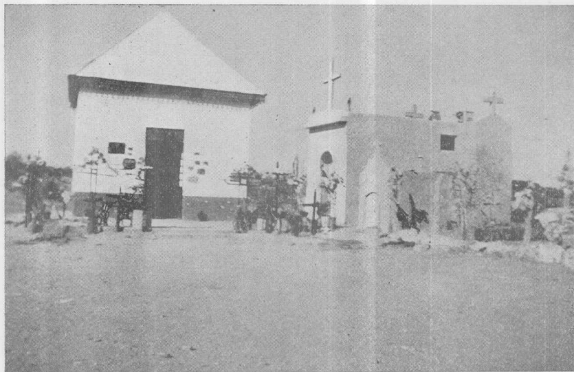
Fig. 7. — Capilla y cementerio de la Difunta Correa. A la derecha la nueva capilla en construcción
