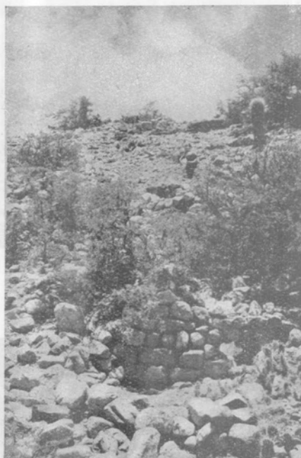
Fig. 4. — Detalle de una de las viviendas cuadrangulares, construída en una quebradita adyacente, a poca distancia del grupo principal de las construcciones.
