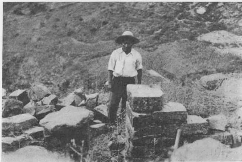
Fig. 52. — a y b , Dos viviendas aborígenes en Huaira-Huasi, en donde se advierte, en la construcción de las puertas, el uso de grandes piedras canteadas
