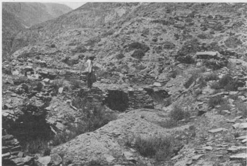
Fig. 9. — a y b , Construcciones en Titiconte, que presentan falsa bóveda, formada por hiladas superpuestas y techumbre de grandes lajas recubiertas de barro amasado con pequeños guijarros
