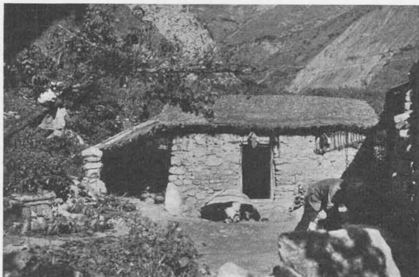
Fig. 46. — Patio interior de una de las casas de la región, en la que se ve, junto a una de las habitaciones, la cocina constituida por la clásica «ramada» de techo oblicuo que aprovecha, en parte, la construcción vecina para completar su somera arquitectura.
