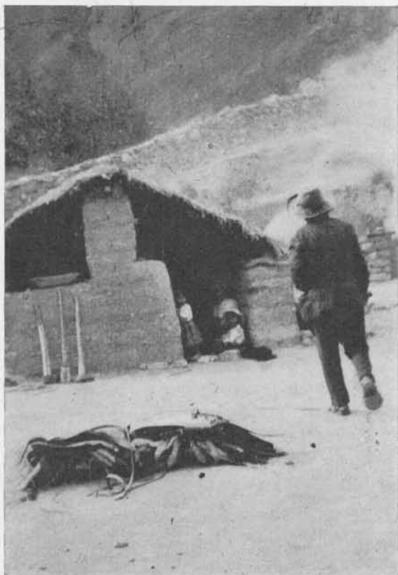
Fig. 31. — La cocina de la casa de Gutiérrez, lugar de reunión de la familia, constituida por una construcción asaz completa, de adobe, con muros laterales más altos y cerrados, y techo de paja recubierta de barro.
