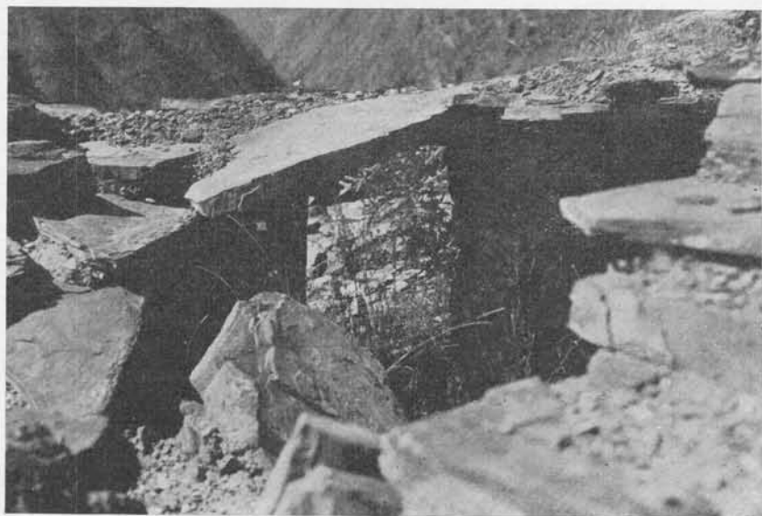
Fig. 63. — a y b , Dos ejemplos de la forma de enmarcar las puertas, formando dinteles y línea de vanos con gruesas piedras, aunque — en lo que respecta a los vanos — también suelen hacerse por medio de material lítico más pequeño rigurosamente alineado.
