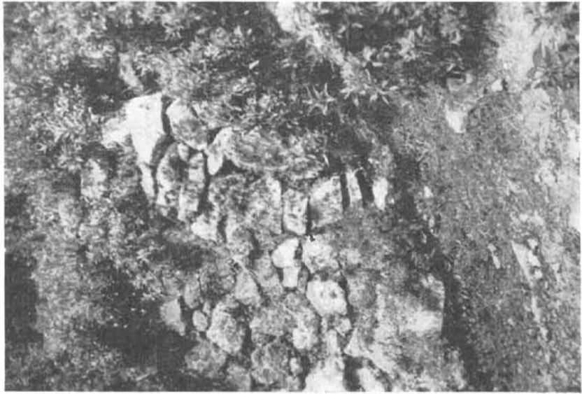
Fig. 29. — a, Pícea indígena de un muro de contención de tierra, que evita que ésta caiga y ciéguen un « ojo de agua », de que se servía el hombre primitivo y que aun utiliza el moderno; b, detalle del aparejo lítico que permite y asegura la salida del agua
