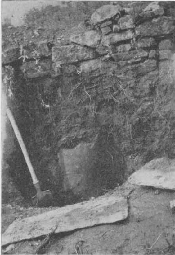
Fig. 21. — Detalle en el cual puede advertirse un « vaso tubular » depositado bajo el cimiento de uno de los muros de una vivienda, en Rodeo Colorado.
