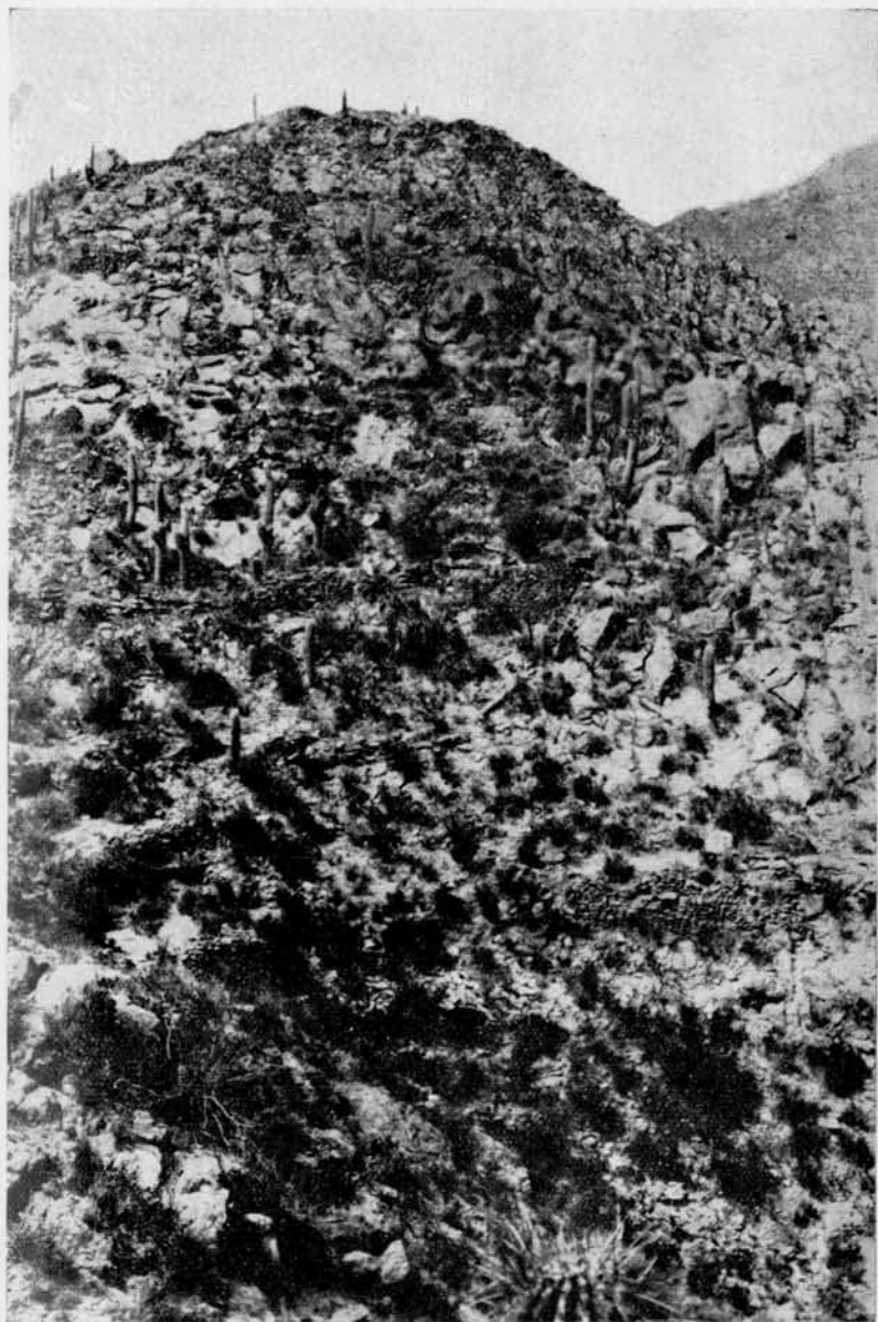
Muros de contención. (Foto tomada por el Ing. Weiser).
